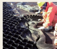
特殊シートの敷設
