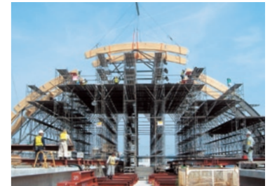
アーチ組み上げ作業
