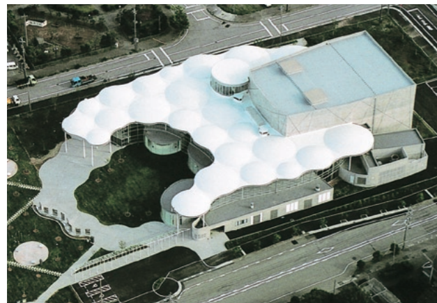
「ラポルトすず」の全景
