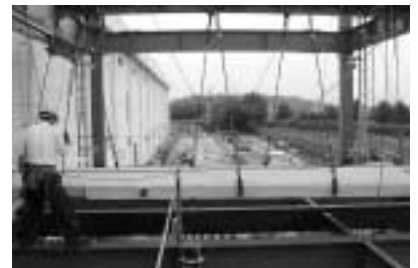
新築事務棟の床に再利用
