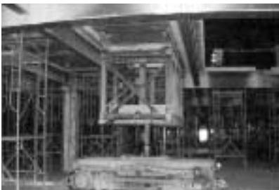
工場棟スラブ床の解体撤去
