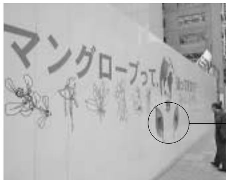
仮囲いと回収箱
