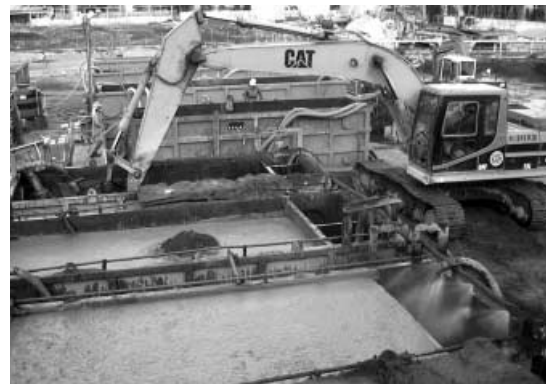
気泡連行法による土壌浄化
