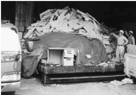
グラスウールの集積状況
