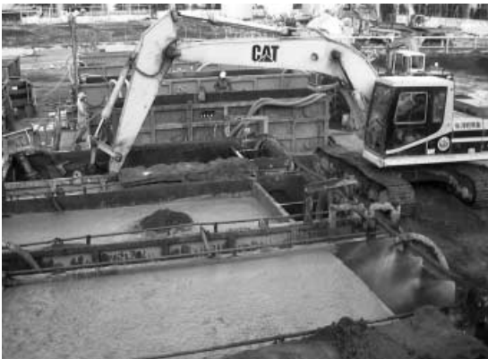
気泡連行法による油汚染土壌の浄化工事
